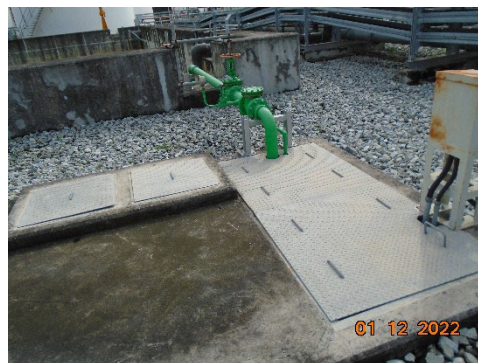
ภาพที่ 2-6 บ่อแยกน้ำ-น้ำมัน
